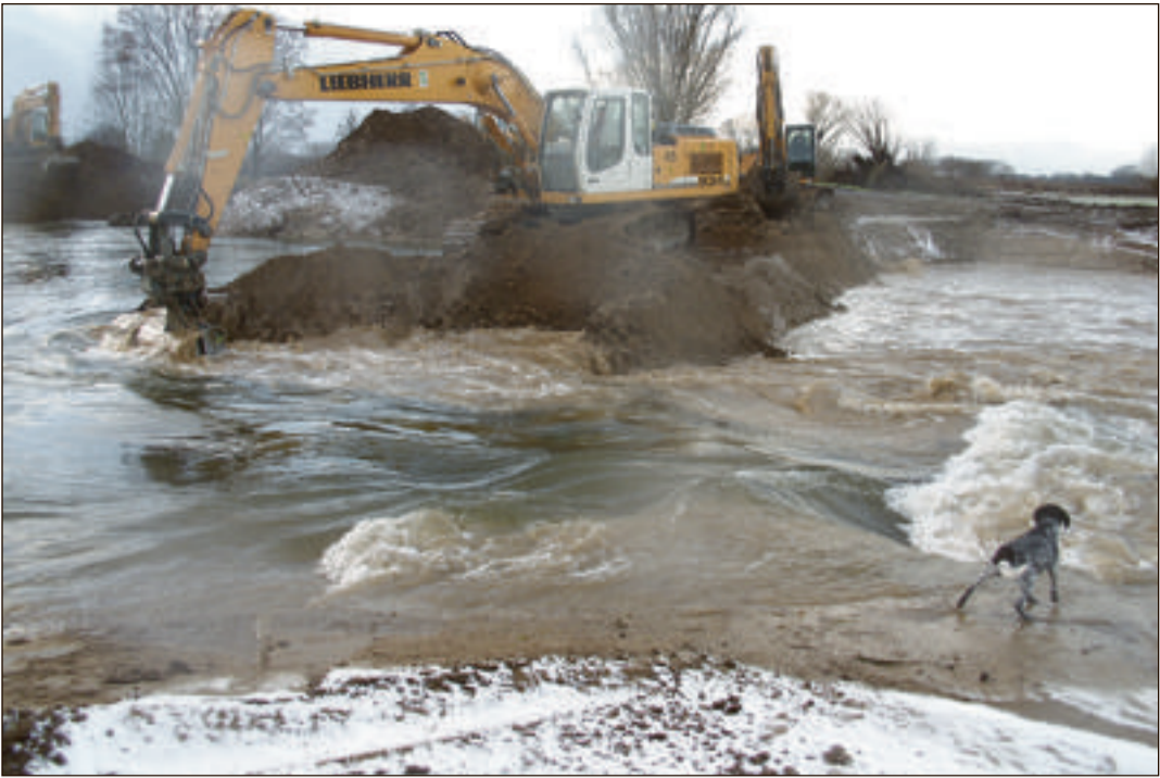
Der Durchstich der neuen Lippe-Schleife in Eickelborn ist geschafft, die Wassermassen fließen jetzt in die rund 600 Meter lange Laufverlängerung.
